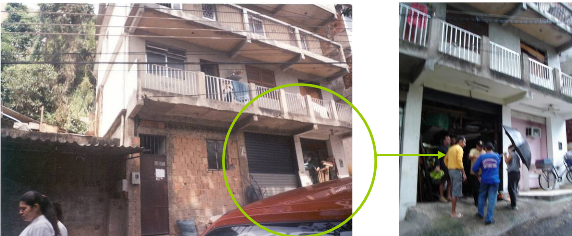
60 e 61 Edificação Mista na Avenida Tenente Francisco Mega em dois momentos. Fonte: Eliene Tozetto, 2000 e 2005.
