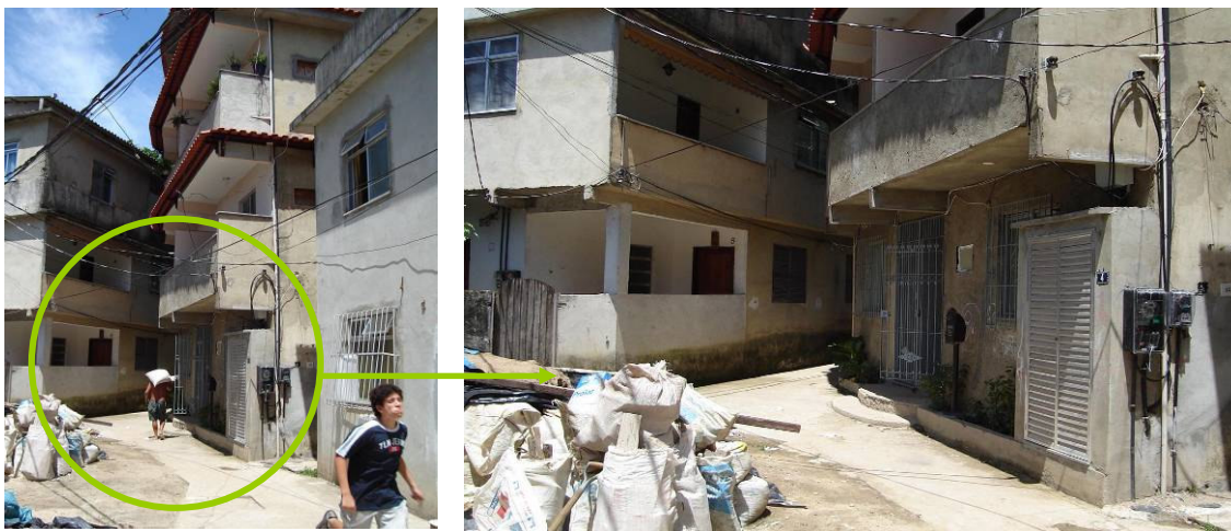
40 e 41 Residências já em alvenaria- mesmo foco das imagens 38 e 39.
