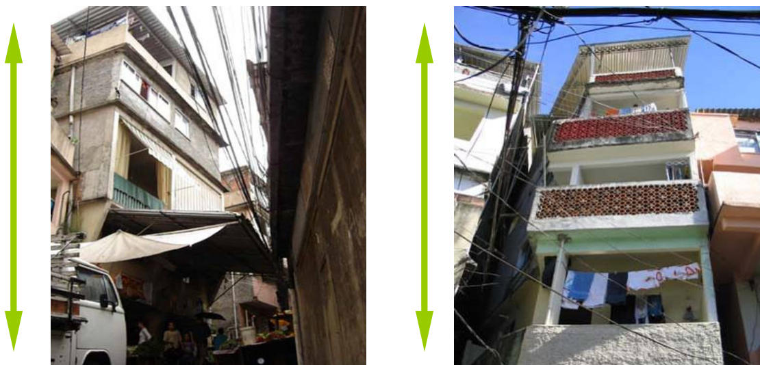
66 e 67 Residências com cinco e seis pavimentos. Fonte: Eliene Tozetto, 2004.
