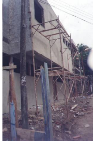
120. Obras Nova Creche Fonte: Associação de Moradores, 2002
