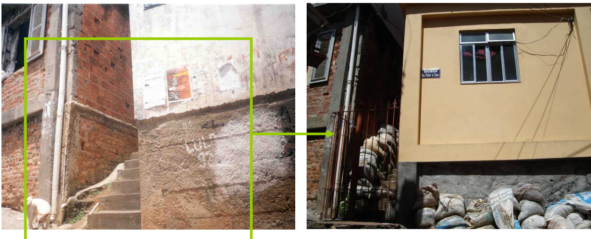
62 e 63 Residência na Avenida Parque da Cidade em dois momentos. Fonte: Eliene Tozetto, 2000 e 2005.
